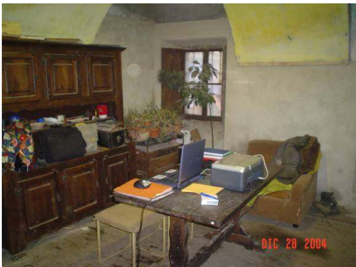
Fig.04. ) ristrutturazione di un locale atto ad ufficio-ricezione.
